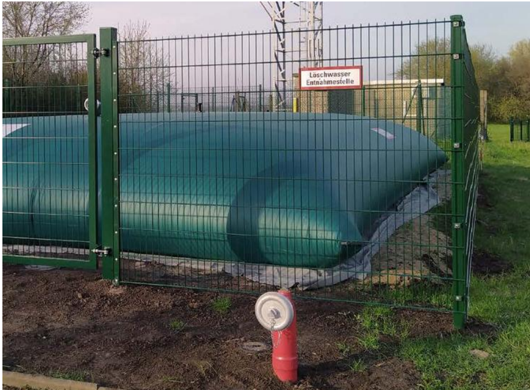
Abbildung 5: Löschwasserkissen und Hydrant
