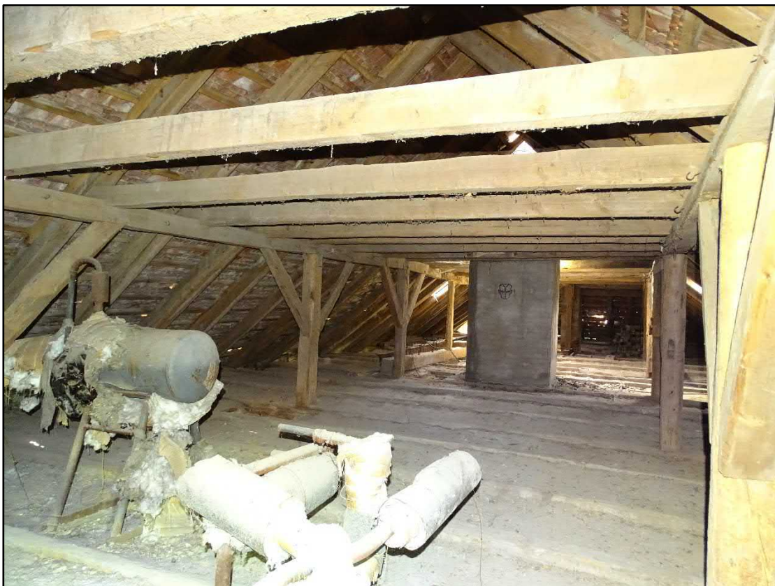
Bild 14 – Gutshaus, Innenbereich, Dachboden
