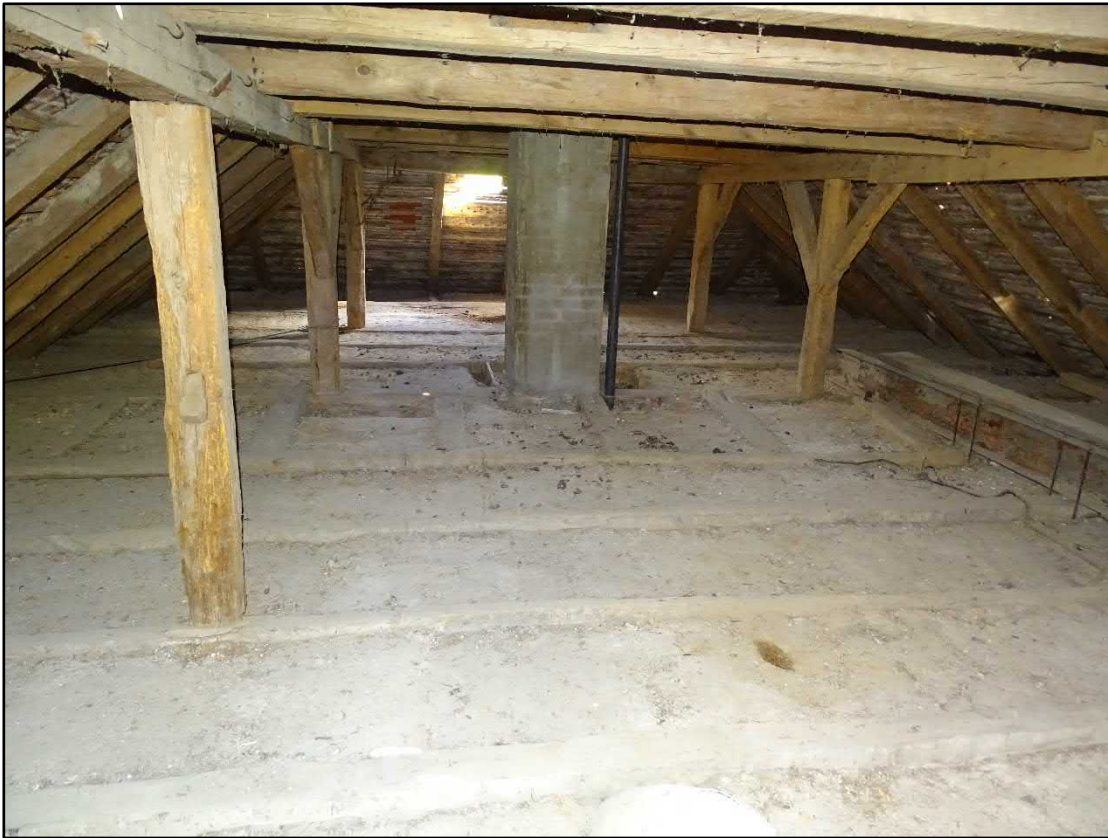
Bild 15 – Gutshaus, Innenbereich, Dachboden
