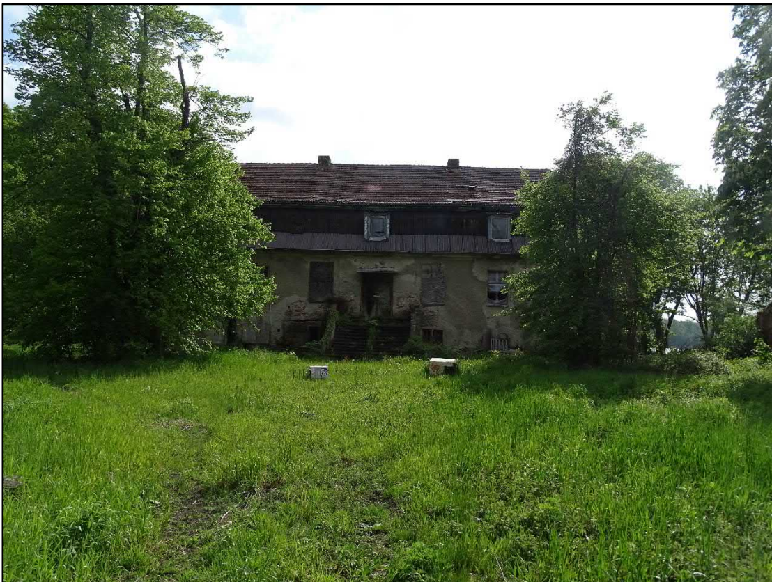
Bild 16 – Gutshaus, Außenbereich, Westseite
