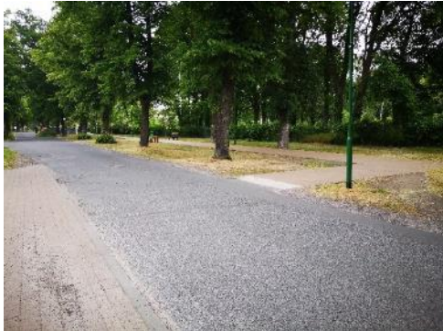
Abb. 10: Fuß- und Radweg (Schulweg) entlang der Seestraße/ Dorfaue mit Blickrichtung Gutspark
