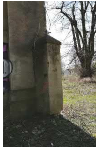
Torpfeiler, Linde im Hintergrund
