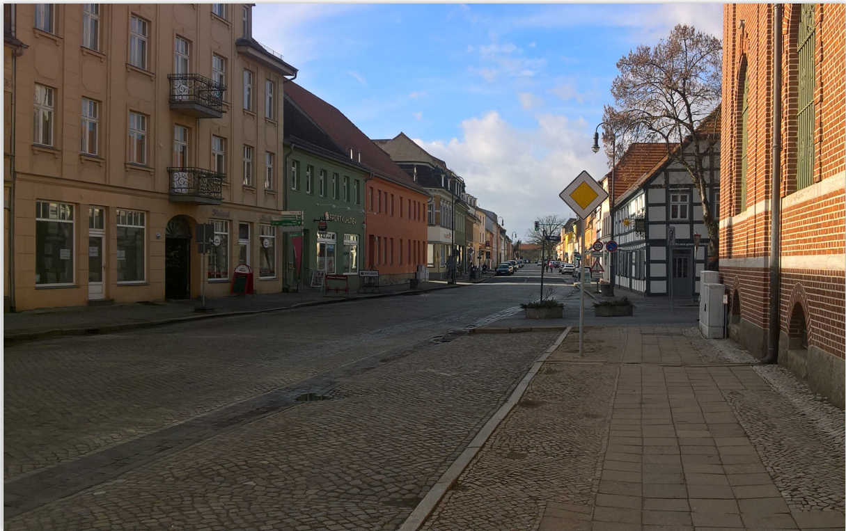
Abbildung 2-3 Gehweg entlang der Großen Straße (Blickrichtung Westen)
