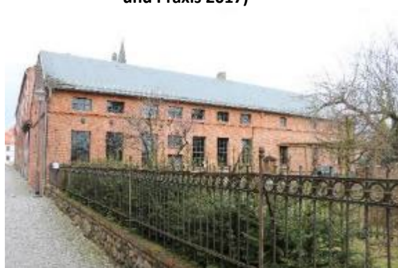
Abbildung 14: Saniertes Quergebäude im östlichen Geltungsbereich (Quelle: Plan und Praxis 2017)
