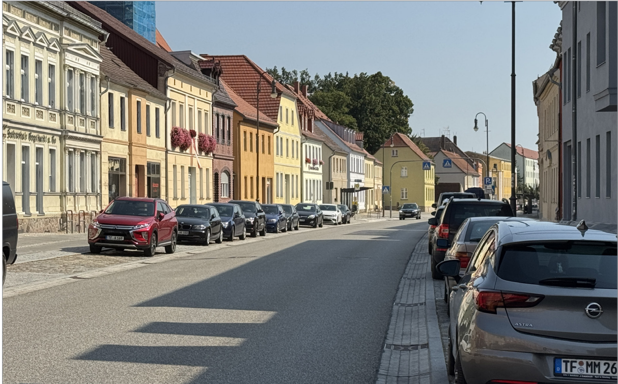
Abbildung 2-1 Bundesstraße B102 (eigene Aufnahme) | Blickrichtung Ost
