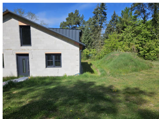
Abbildung 5: Blick auf Rohbau im Westen
