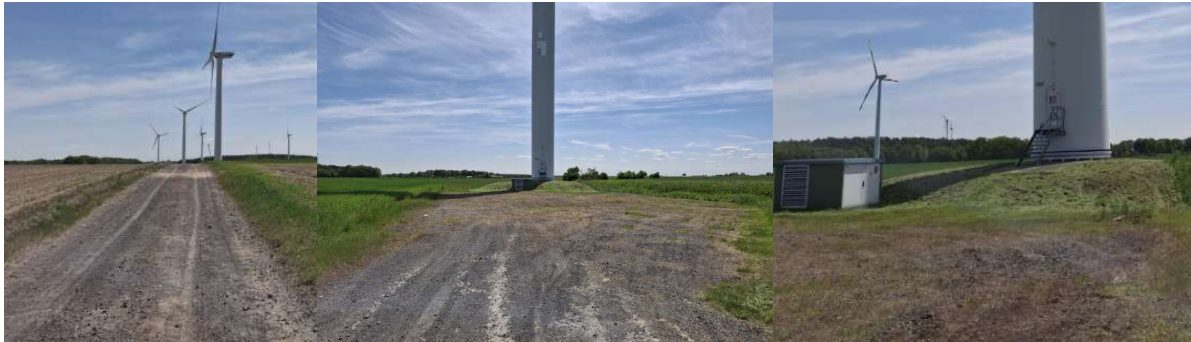
Abbildung 15: Zufahrt (teilversiegelte Wege; linkes Bild), Kranstellfläche, Turm, Fundament und Trafo der am Buschfeldgraben stehenden Bestandsanlage (WEA; mittleres und rechtes Bild).
