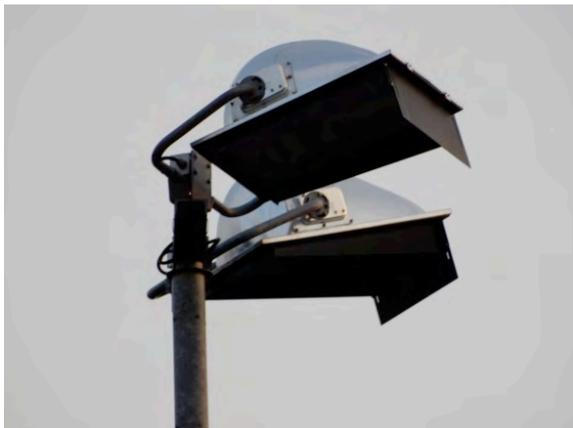
Abbildung 7: Flutlichtmasten Ost mit nachträglich befestigter Abblendvorrichtung. Foto: ibeno, 05.04.19
