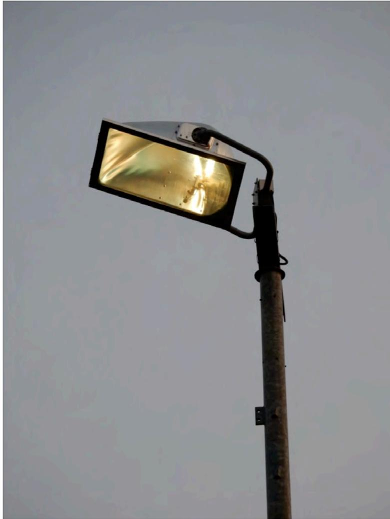
Abbildung 9: Flutlichtmasten West ohne Abblendvorrichtung. Neigungswinkel. Foto: ibeno, 05.04.19
