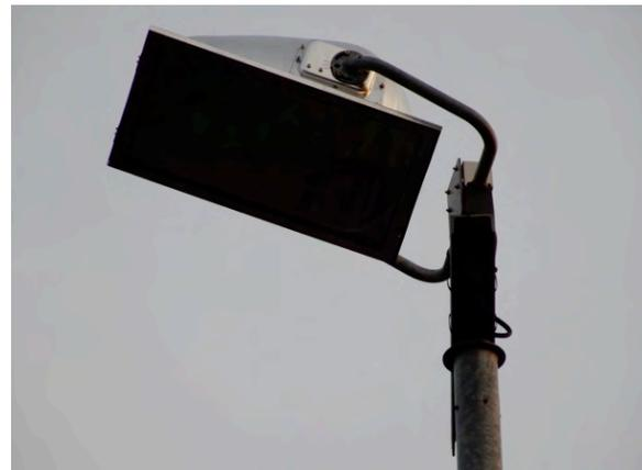
Abbildung 8: Flutlichtmasten West ohne Abblendvorrichtung und augenscheinlich größerem Neigungswinkel Foto: ibeno, 05.04.19
