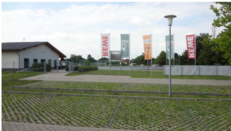
Abb. 48 Die Parkstellflächen im Eingangsbereich von der Karl-Marx-Straße aus
