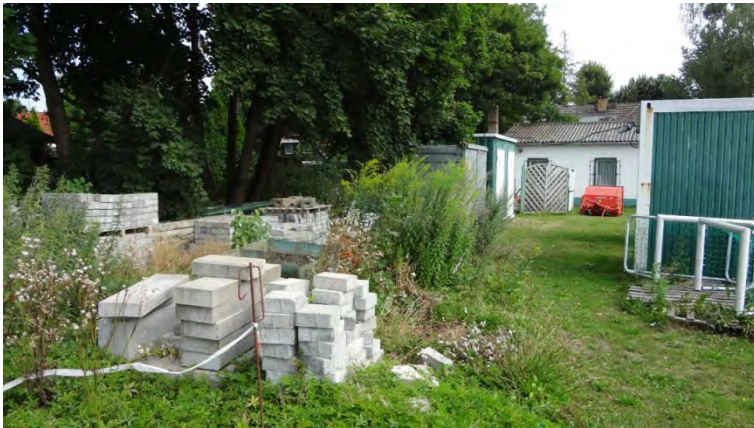
Abb. 49 Lagerflächen mit Baumaterialien vor dem Graben
