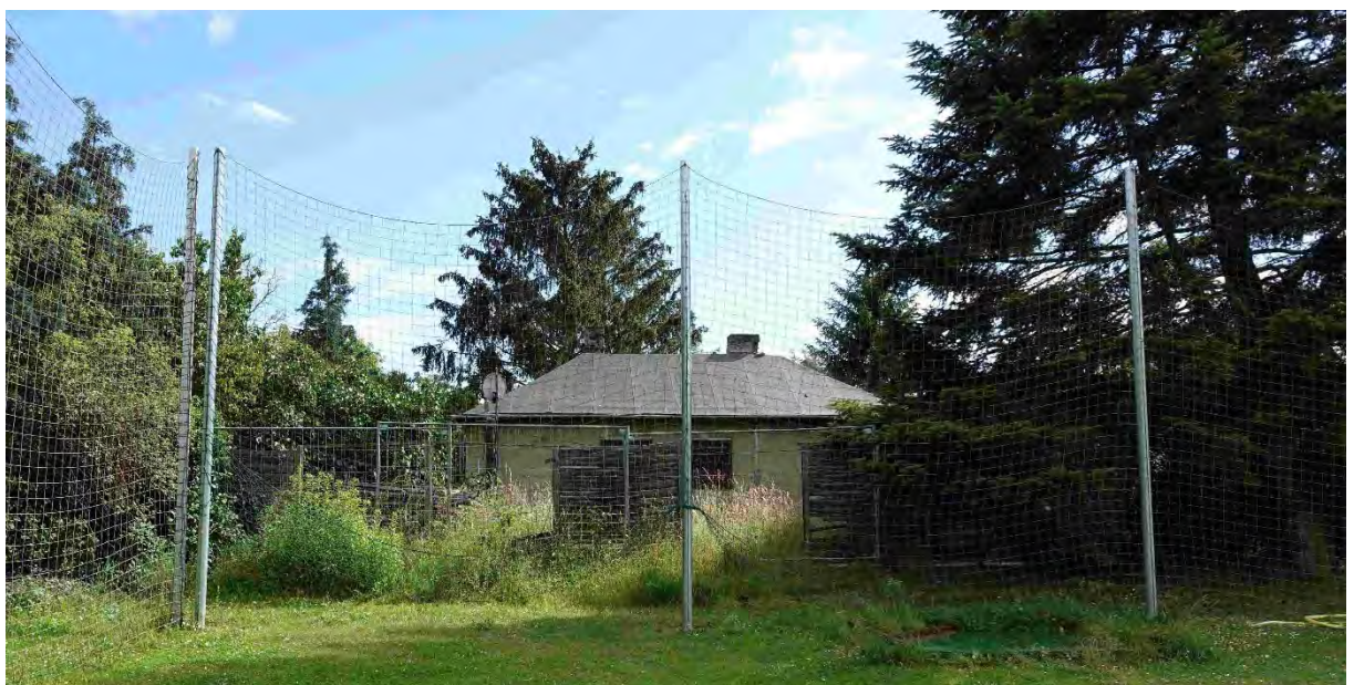
Abb. 64 Blick von den nördlich gelegenen Sportplatzanlagen auf das Flurstück 305, Flur 2, Gemarkung Brieselang mit dem aufgegebenen Wohnhaus © Steffen Pfrogner 17.08.2024
