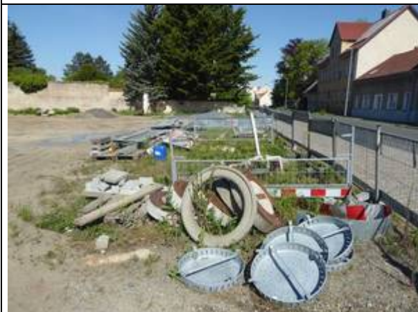
Foto 5: Lagerfläche von Baumaterialien (Foto: Wiesner, 12.5.25)
