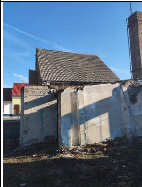
Foto 3: Garagengebäude - Südwestfront (Foto: Wiesner, 5.11.25)
