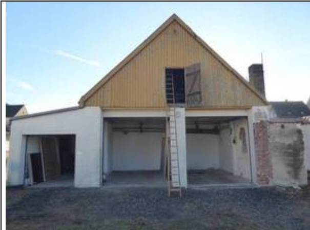
Foto 1: Garagengebäude - Nordwestfront (Foto: Wiesner, 5.11.25)
