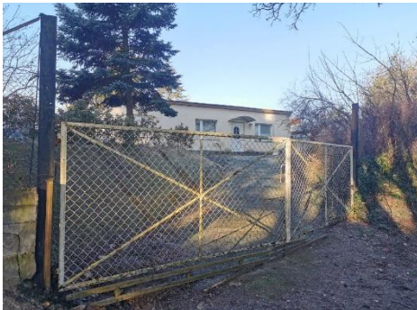
Abb. 8 Einfamilienhaus am „Borgsdorfer Weg“, Blickrichtung Nordwesten
