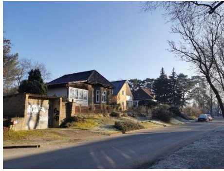
Abb. 5: Einfamilienhäuser an der „Havelstraße“, Blickrichtung Osten
