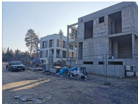
Abb. 13: In Bbau befindliche Wohngebäude am „Fischerwall/Wendenplan“, Blickrichtung Süden
