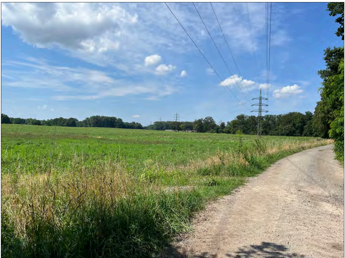
Abb. 7: 110 kV-Leitung Perleberg - Kyritz (eigenes Foto)
