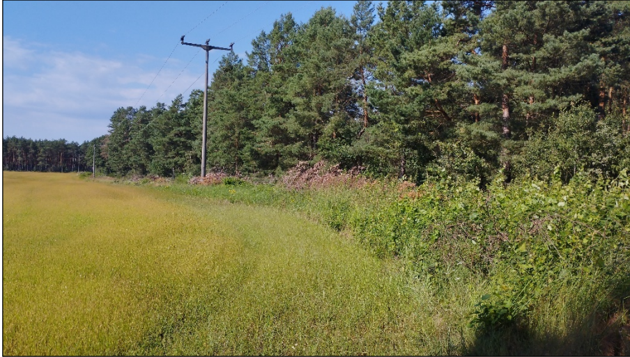
20-kV-Freileitung mit parallel verlaufenden unbefestigten Waldweg; unterhalb der Leitung Ruderalflur mit Pappelaufwuchs, Brombeeren, Ginster und abgelegtem Ast-/Strauchwerk; sporadisch Heidekrautvorkommen
