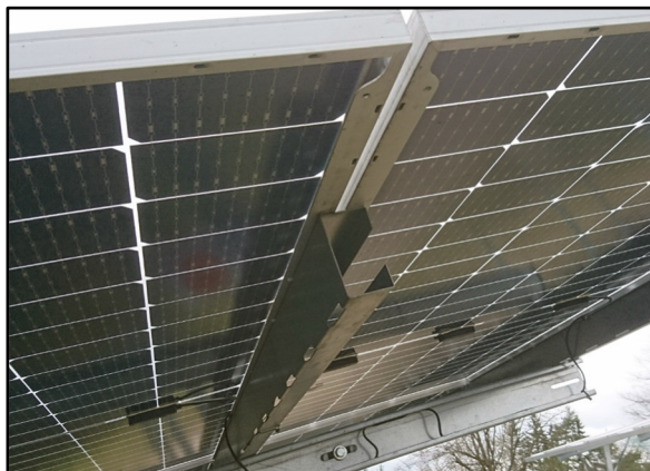
Foto "Regenwasserverteilschiene" Q: SUNfarming
