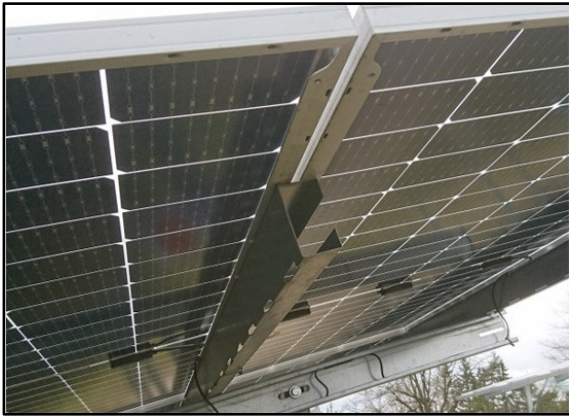
Foto "Regenwasserverteilschiene" Q: SUNfarming
