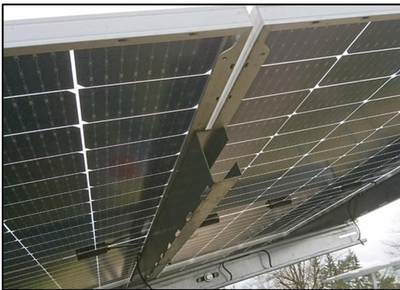
Abb. 7 - Foto "Regenwasserverteilschiene" Q: SUNfarming
