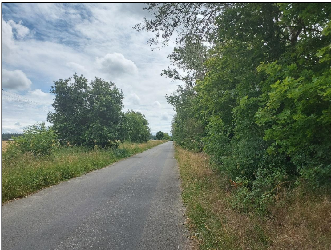
Abbildung 2: Gehölzstrukturen an der Straße des Friedens Blick Richtung Süden
