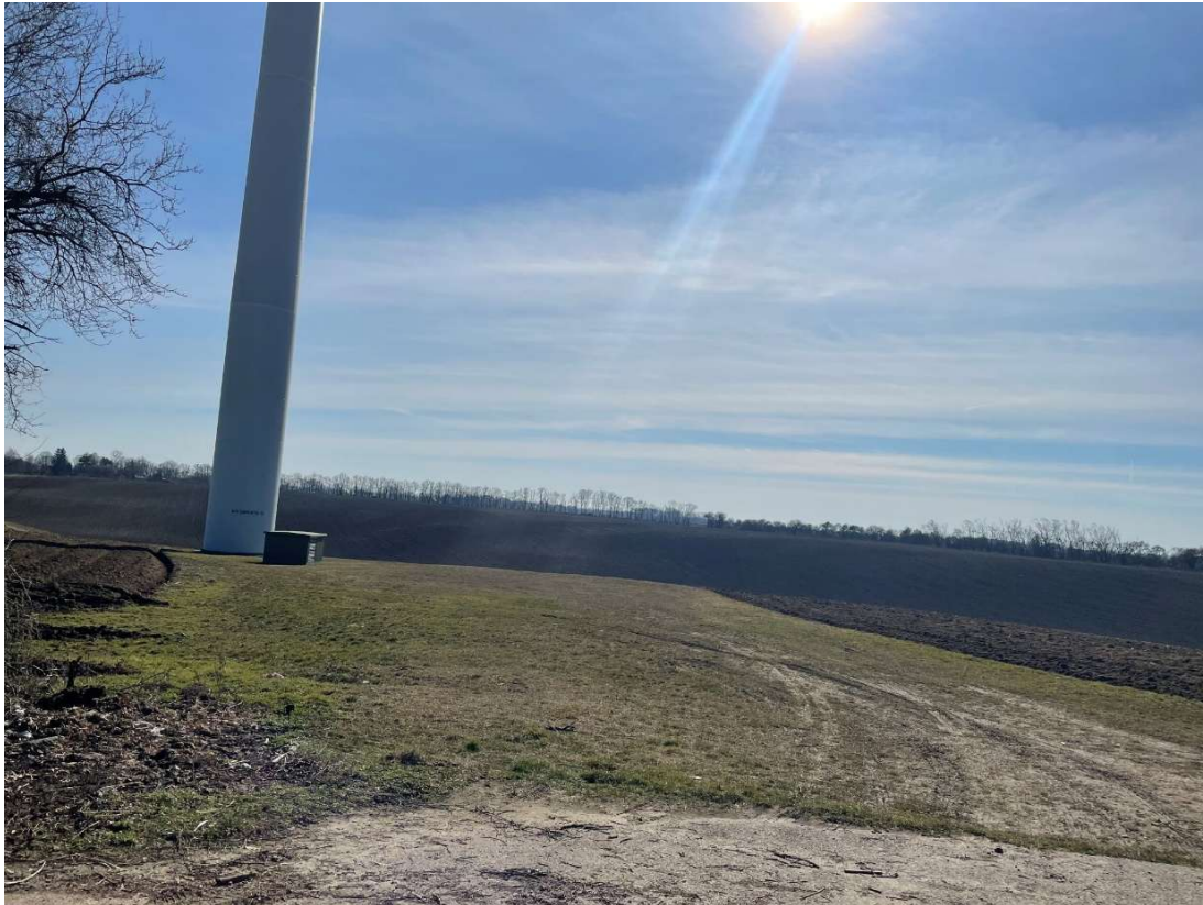
Kranstellfläche und WEA-Standort südlich der Straße in den Windpark Lebus
