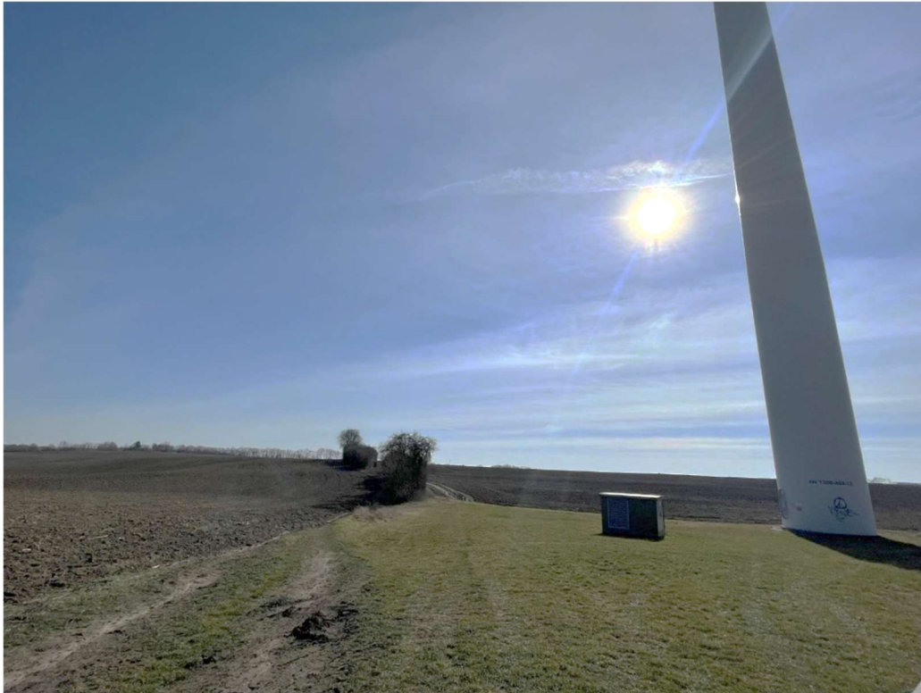
Kranstellfläche und WEA-Standort südlich der Straße in den Windpark Lebus im Bereich Bau- feld 3. Eingriffe in das randlich liegende Gehölz sind durch Festsetzung 4.4 ausgeschlossen.
