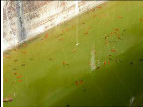
Foto 29: Goldfische im Belebtschlammbecken (Foto: Wiesner, 30.4.24)
