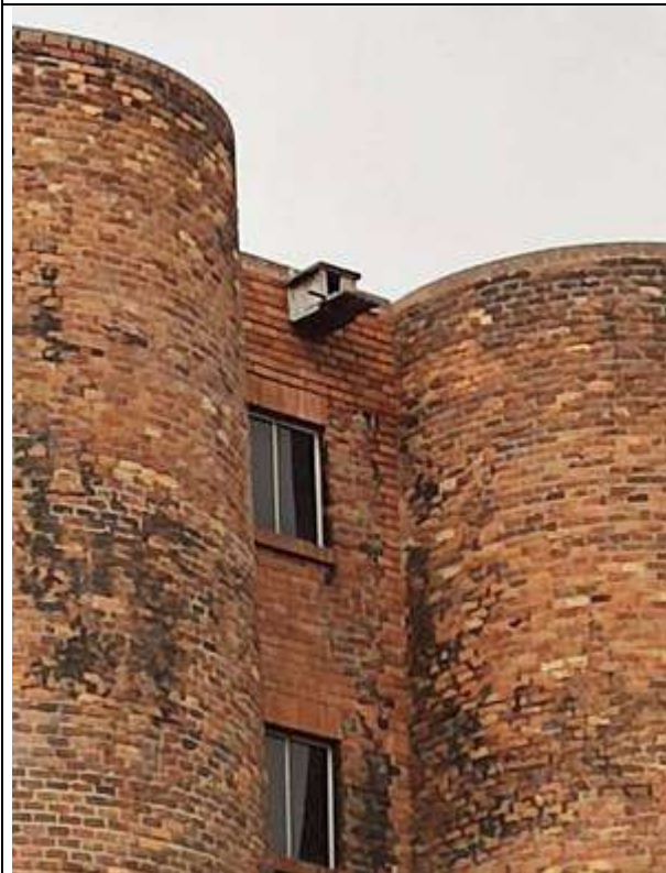
Foto 27: Turmfalkennistkasten an einem Bioturm (Foto: Wiesner, 8.4.24)
