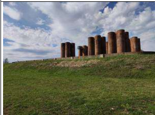
Foto 7: Mährasen und südlicher Böschungsbereich des Belebtschlammbeckens in der SOBF1 (Foto: Wiesner, 5.4.24)
