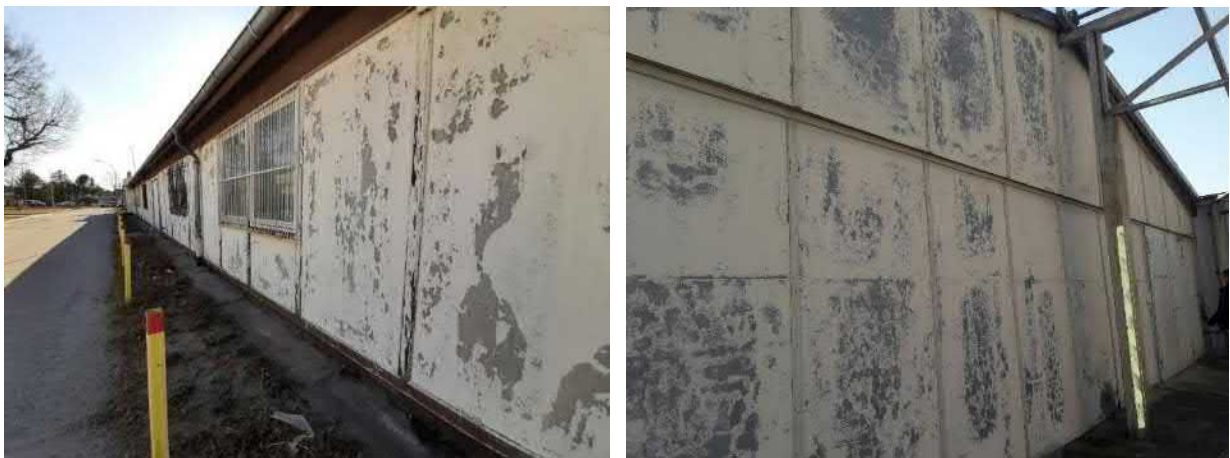
Abbildung 5.1-10: Östl. Längsseite Gebäude E / nördl. Stirnseite Gebäude E
