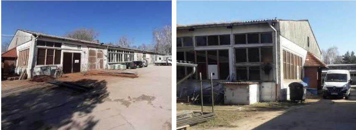
Abbildung 5.1-2: Östl. Längsseite Halle A / westl. Längsseite Halle A
