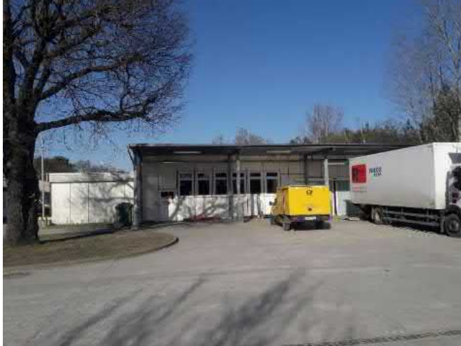
Abbildung 5.1-11: Gebäude F, Hauptgebäude Post
