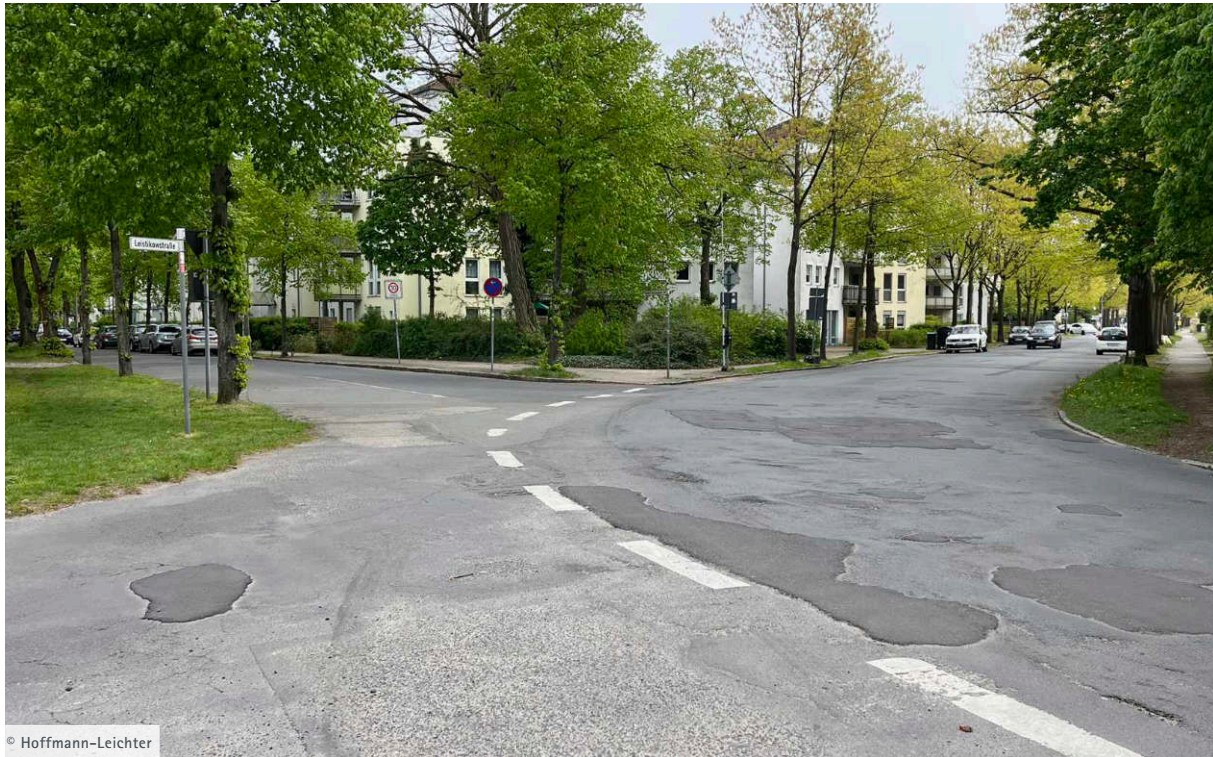
Bild 1 Knotenpunkt Rudolf-Breitscheid-Straße / Erich-Weinert-Straße - Leistikowstraße | Blickrichtung Südosten
