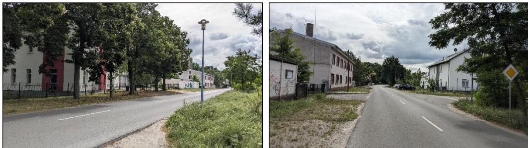
Abbildung 3: Leistikowstraße, Wohngebäude (links) und Funktionsbau (2023)
