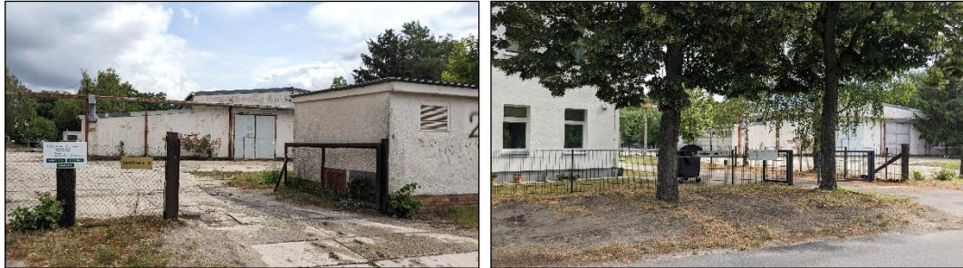
Abbildung 2: Gewerblich genutzter Bereich, einzelstehendes Wohngebäude (rechtes Bild, linker Rand) (2023)
