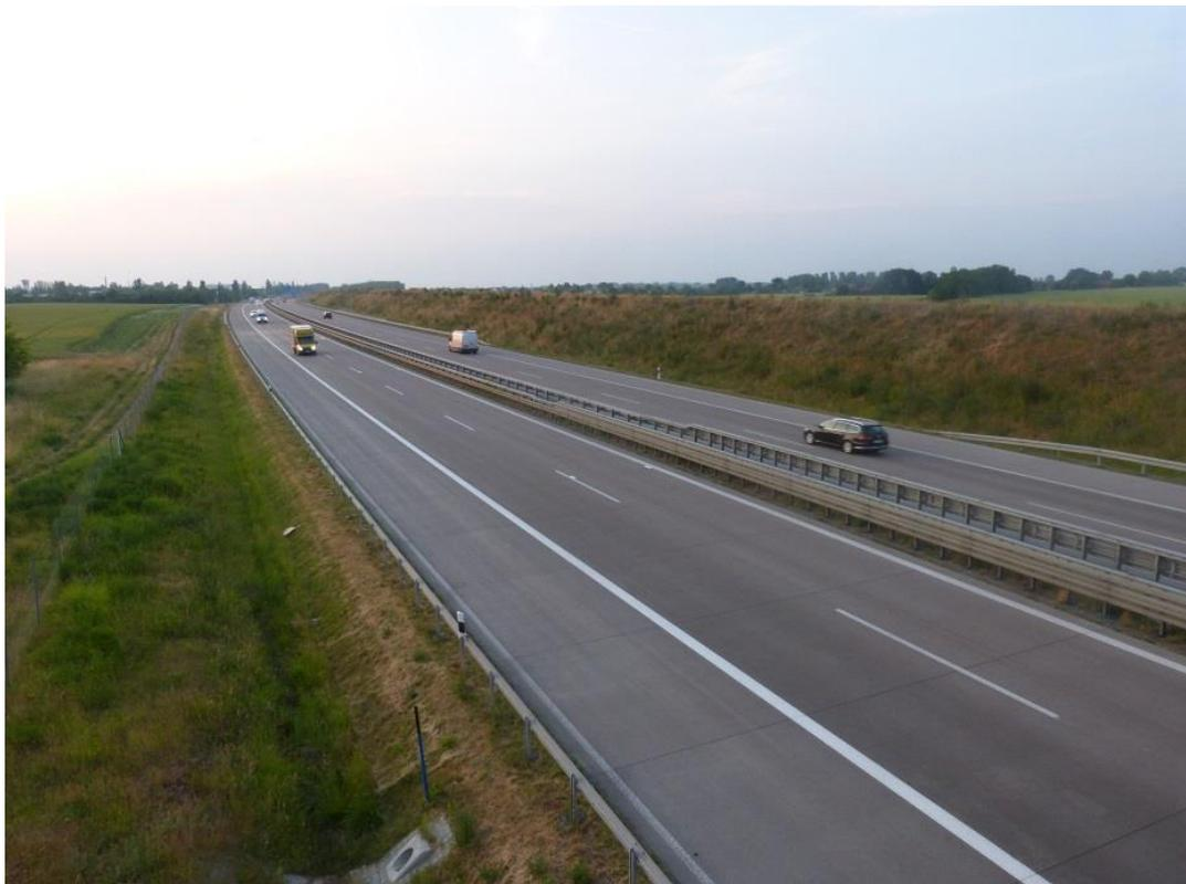
Bild 22: Trockener temporärer Graben zur Fahrbahntwässerung der A24
