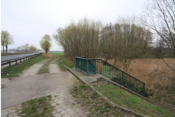
Abb. 8: Durchlas des Zülowgrabens unter der B96
