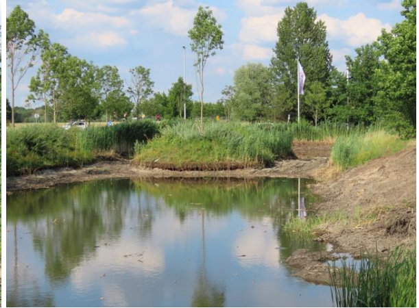
Abb. 15: RHB während der Baumaßnahmen
