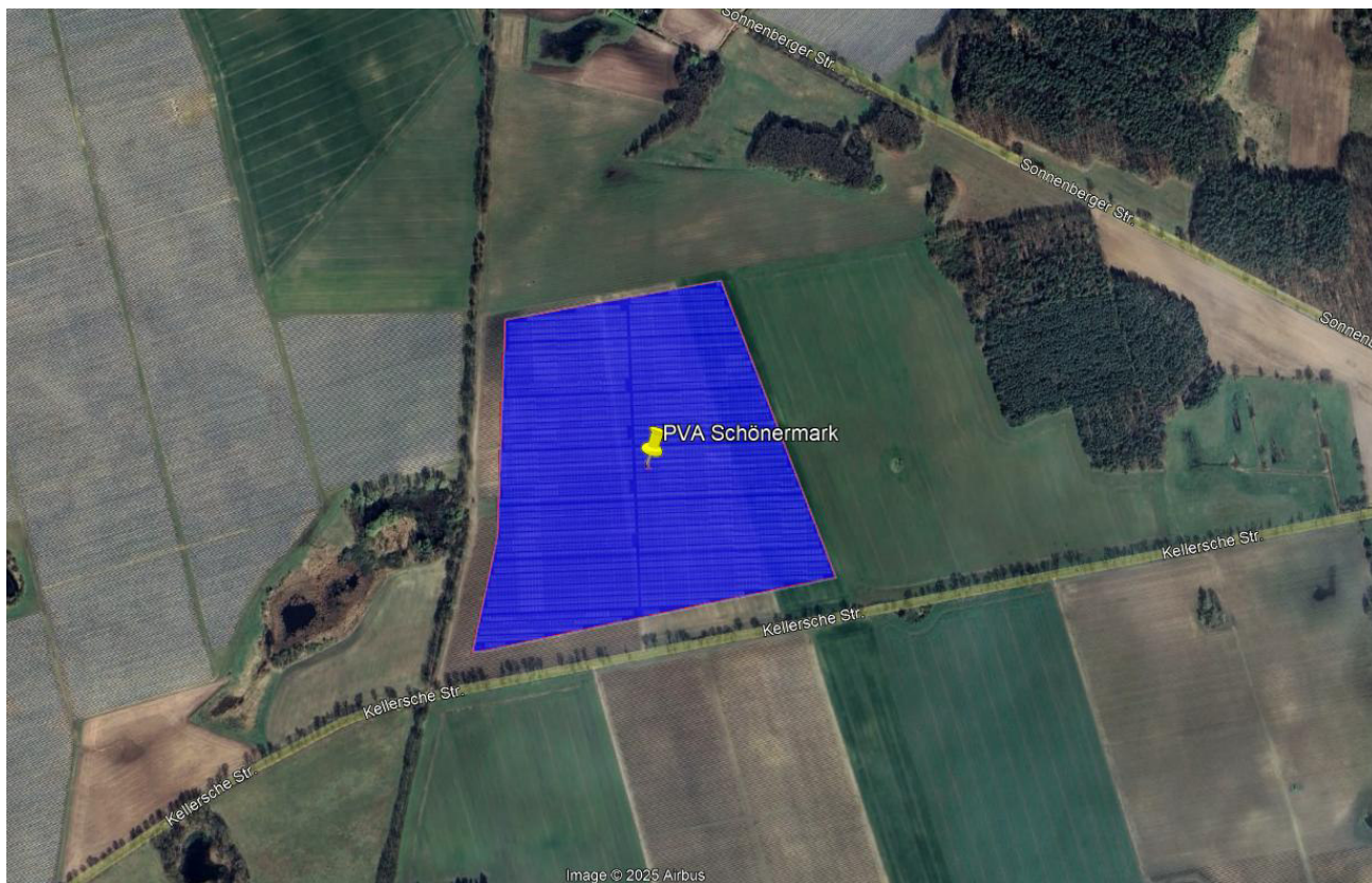
Bild 2.2: Luftbild der PV-Anlage (Quelle: Google Earth / SolPEG)
