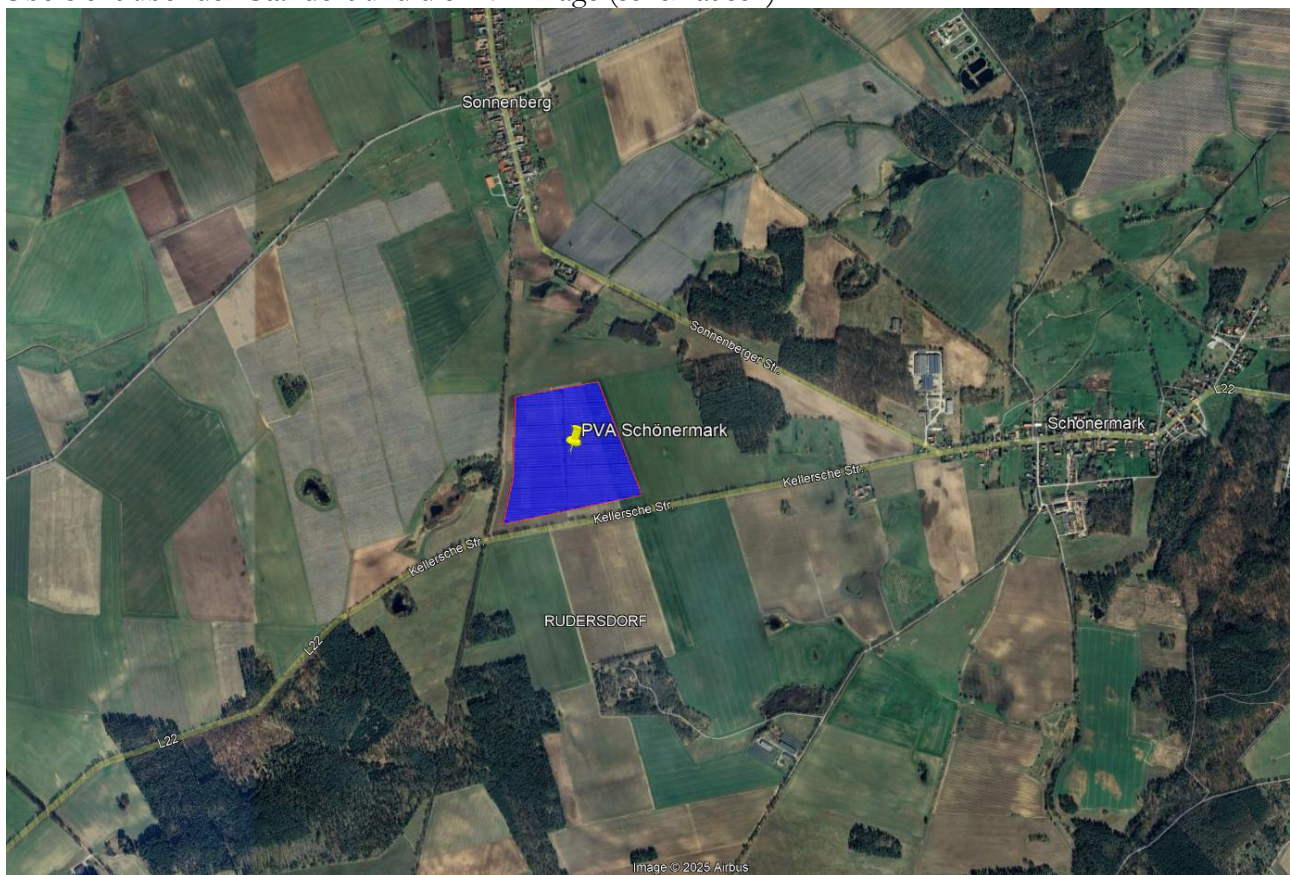
Bild 2.1: Luftbild der PV-Anlage (Quelle: Google Earth / SolPEG)
