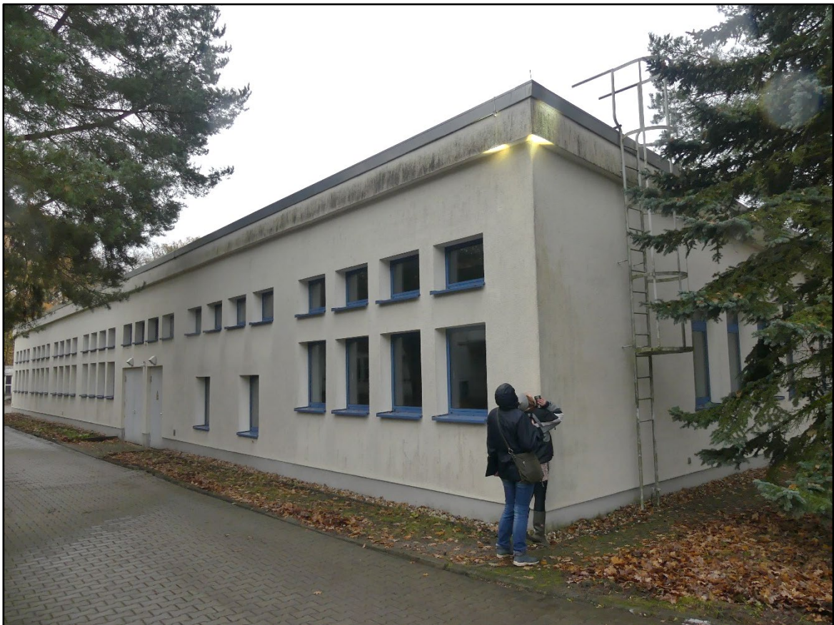
Bild 32 – Gebäude mit Spaltraum unterhalb der Attika im Dachbereich
