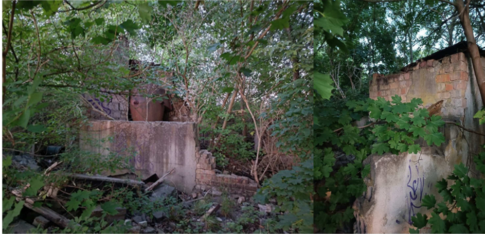
Abbildung 7: Baulichkeit innerhalb der Fläche C
