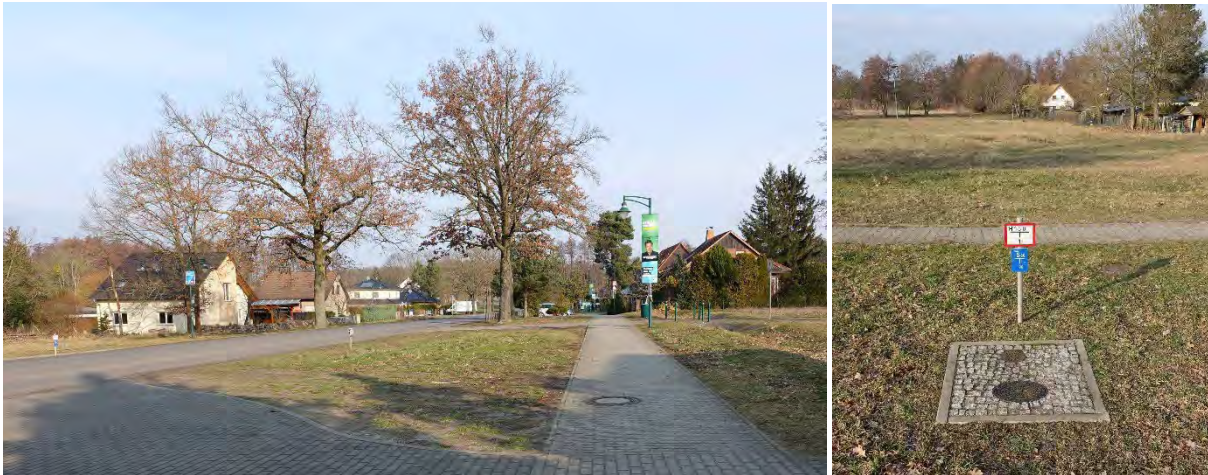
Abb. 19 Hydrant (DN 150) außerhalb des räumlichen Geltungsbereichs in Gegenüberlage der Zufahrt zum Plangebiet an der Chaussee © Steffen Pfrogner 08.02.2025
