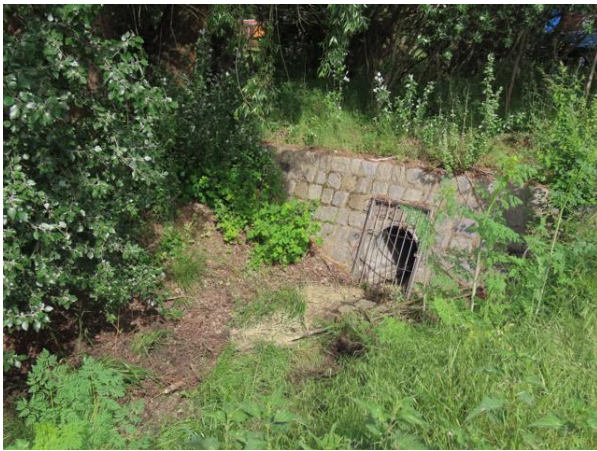
Abb. 14: Ausfluss des verrohrten Grabens an dem Stichweg der Seebadallee
