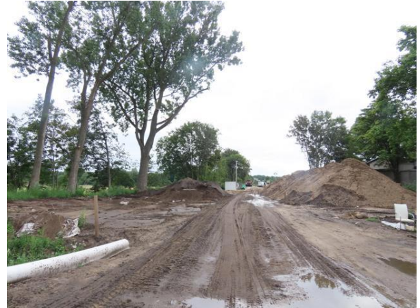
Abb. 5: Baustraße im Südwesten des B-Plangebietes
