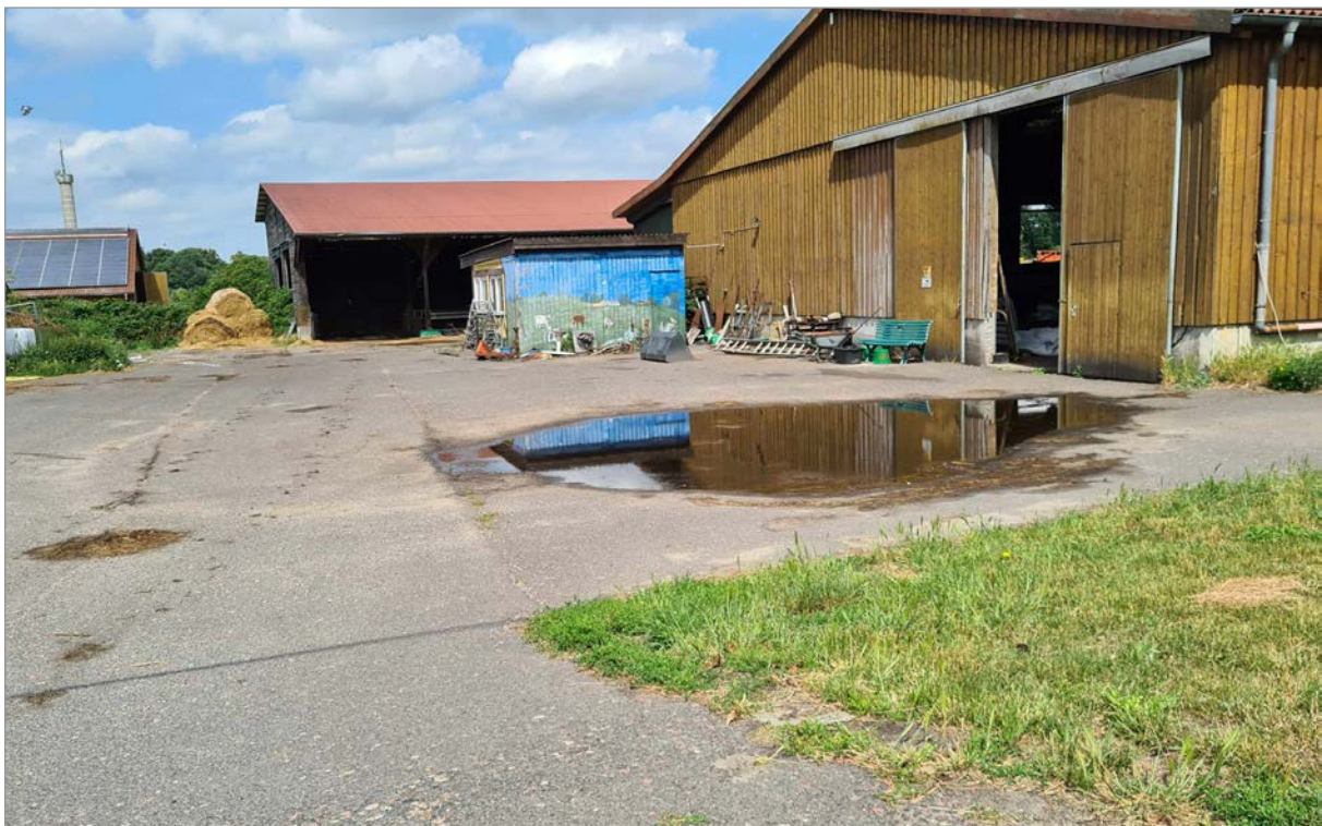
Abbildung 3-5 Stallgebäude Luchstraße 10 (STALL_1, STALL_3) | Blickrichtung nach Westen
