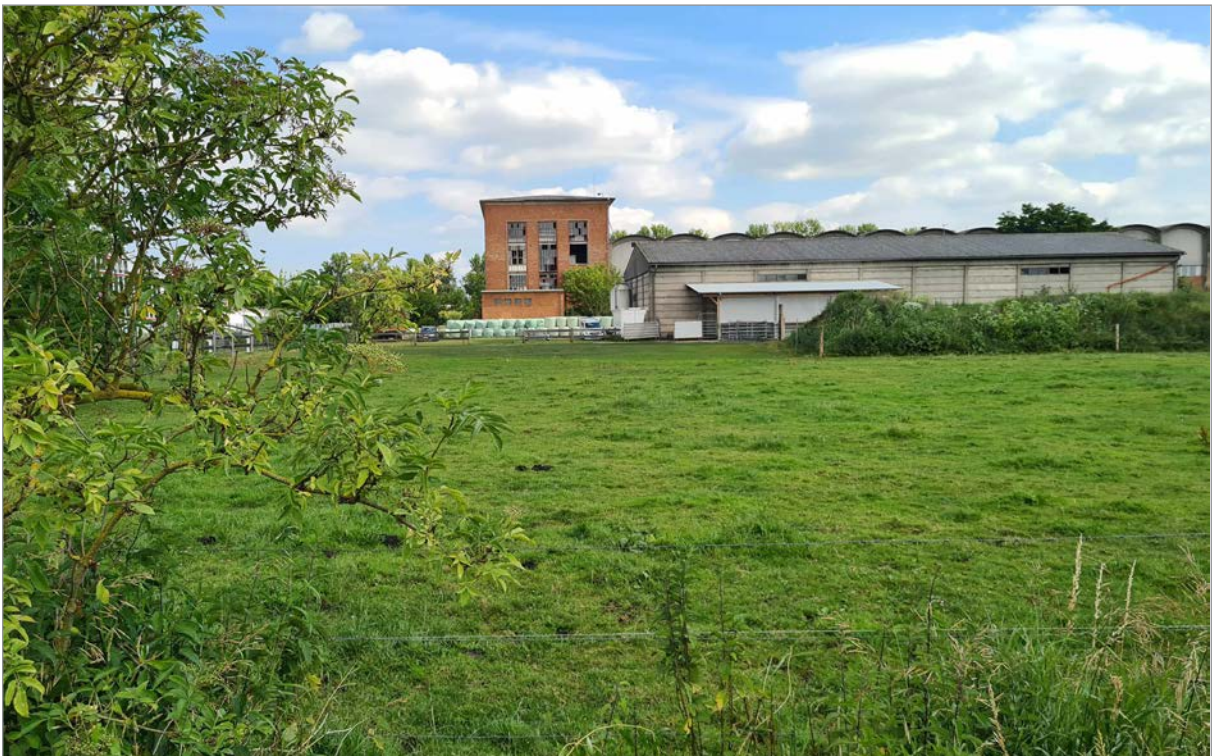
Abbildung 3-7 Stallgebäude nordöstlich des Plangebiets (STALL_4) | Blickrichtung nach Norden
