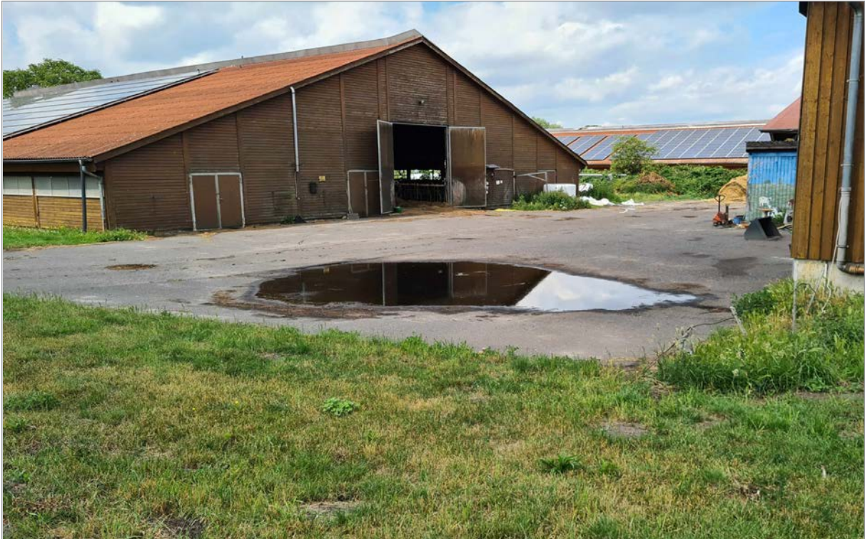
Abbildung 3-6 Stallgebäude Luchstraße 10 (STALL_2) | Blickrichtung nach Südwesten
