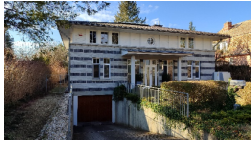
Abb. 24: Wohngebiet am Meisenweg / entlang Bahnhofstraße
