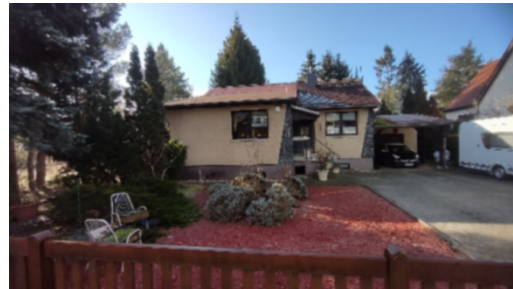
Abb. 28: Wohngebiet am Meisenweg / entlang Bahnhofstraße
