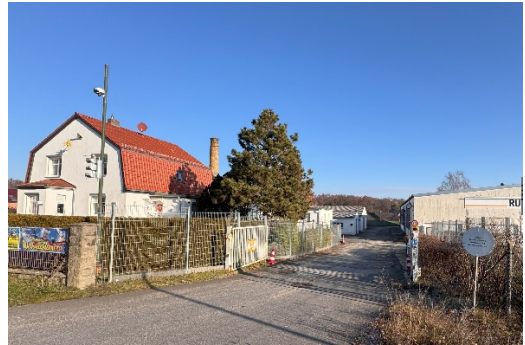
Abb. 19: Ruhlsdorfer Straße - Westliche Wohnbebauung und Gewerbe
