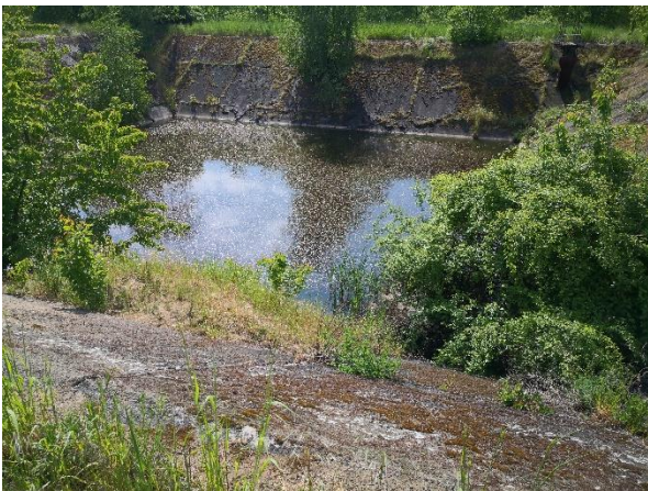
Abbildung 4: Rückhaltebecken mit sehr steilen und glatten Ufern. Foto am 19.05.2023
