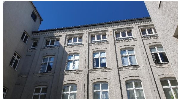
Abbildung 8: Fassade des Gebäudekomplexes, Ostseite
