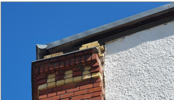
Abbildung 19: Dachkante mit Attikablech, Blick von Mühlenstraße
