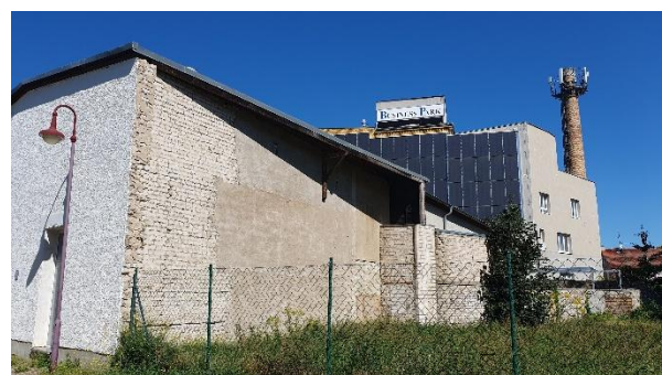
Abbildung 20: Attikablech an Dachkante, Blick von Mühlenstraße
