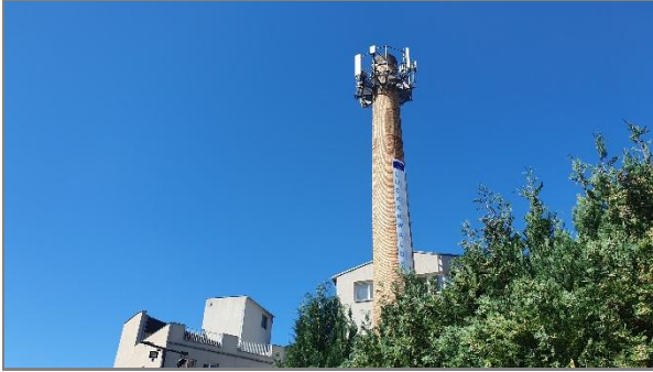
Abbildung 9: Alter Schornstein genutzt als Seendemast
