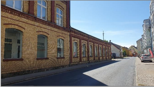
Abbildung 15: Gebäudeseite von Trebbiner Straße
