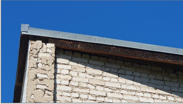
Abbildung 21: Dachkante mit Attikablech, Detailansicht
