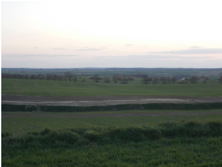
Abb. 4: Arbeitsstreifen und Mutterbodenwall der Erdgastrasse durchziehen die Fläche
