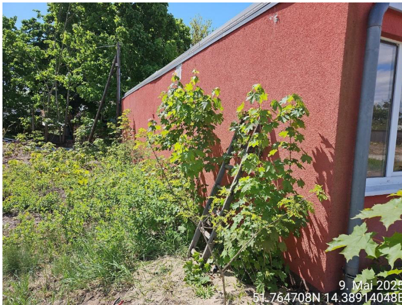
Abbildung 35: Blick auf den zu schützenden Jungaufwuchs am Ostgiebel des Gebäudes (Quelle: BAGU, 2025)
