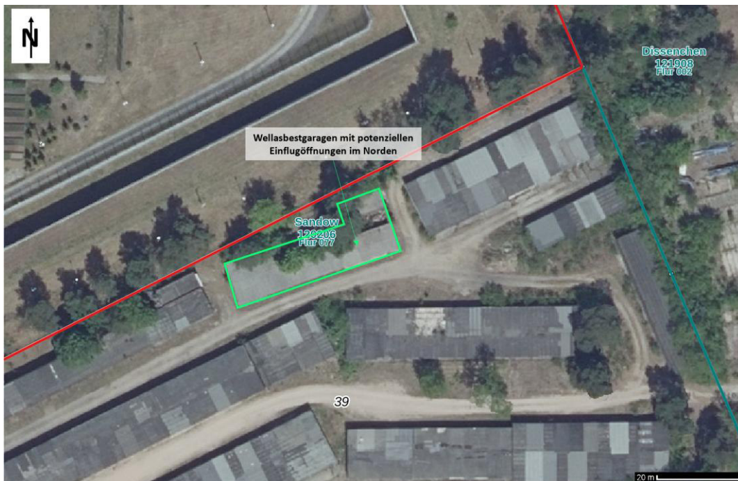
Abbildung 9: Wellasbestgaragen mit potenziellen Einflugöffnungen im Norden (Quelle: BrandenburgVier, 2025)
