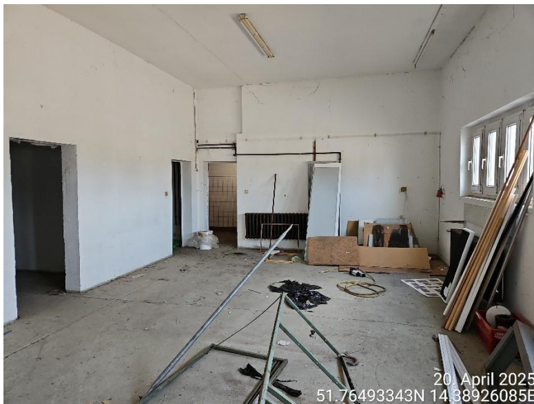
Abbildung 20: Blick in das Teilobjekt „2“ (Quelle: BAGU, 2025)
