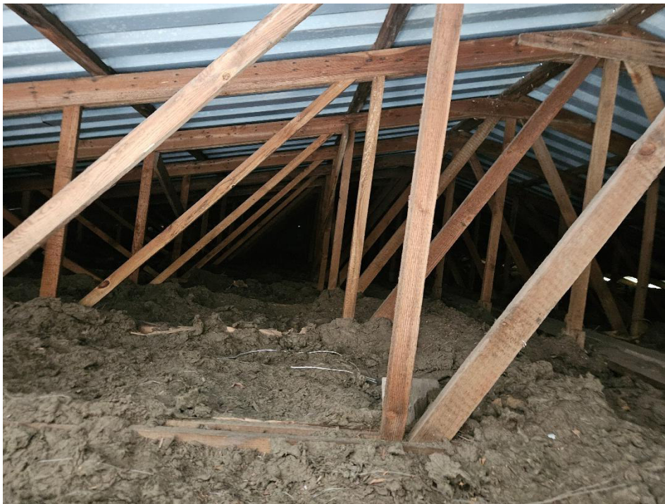
Abbildung 21: Blick in den Dachinnenraum des Teilobjektes „2“ (Quelle: BAGU, 2025)
