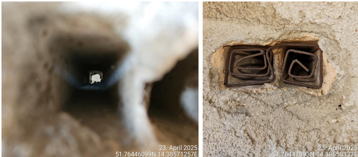
Abbildung 4: Direkter Vergleich zwischen barrierefreien (links) und unzugänglichen Lüftungsöffnungen (rechts) (Quelle: BAGU, 2025)
