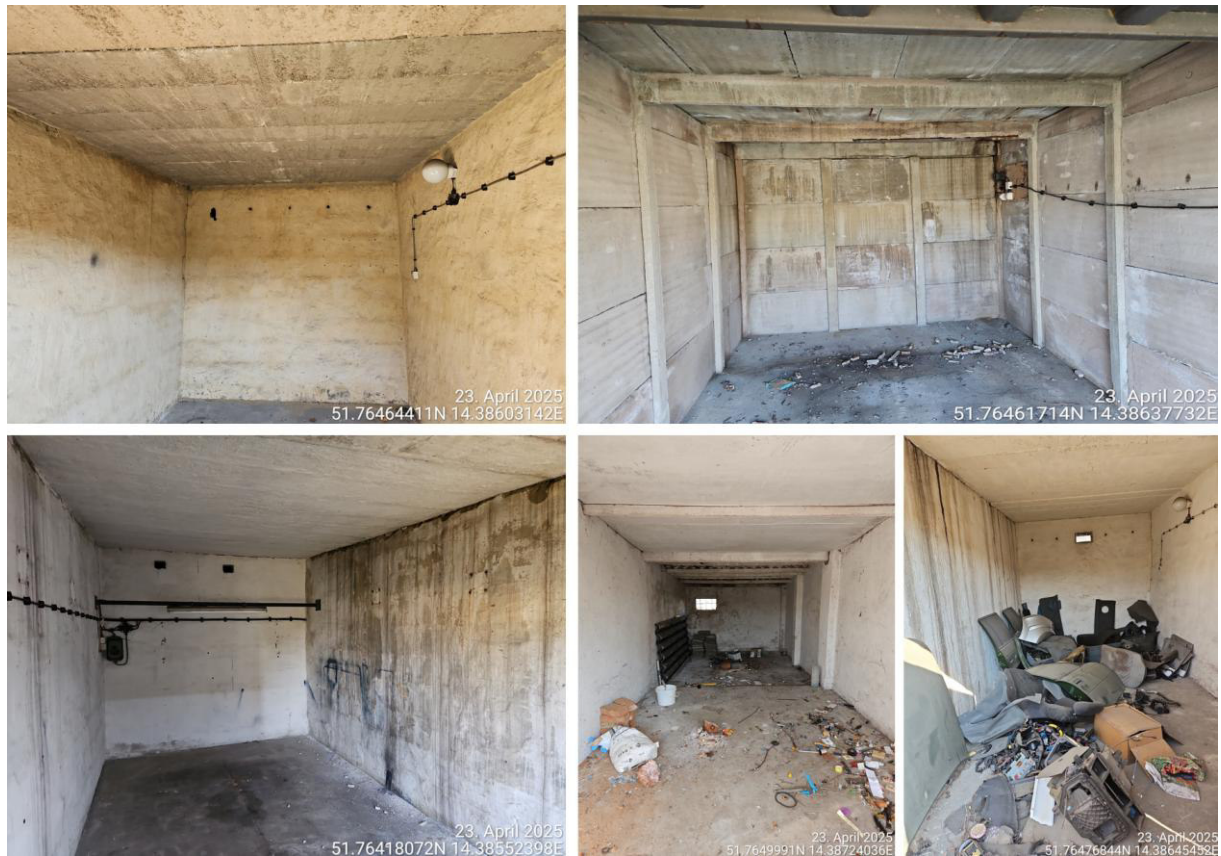
Abbildung 6: Ansicht von exemplarischen Garageninnenräumen (Quelle: BAGU, 2025)
