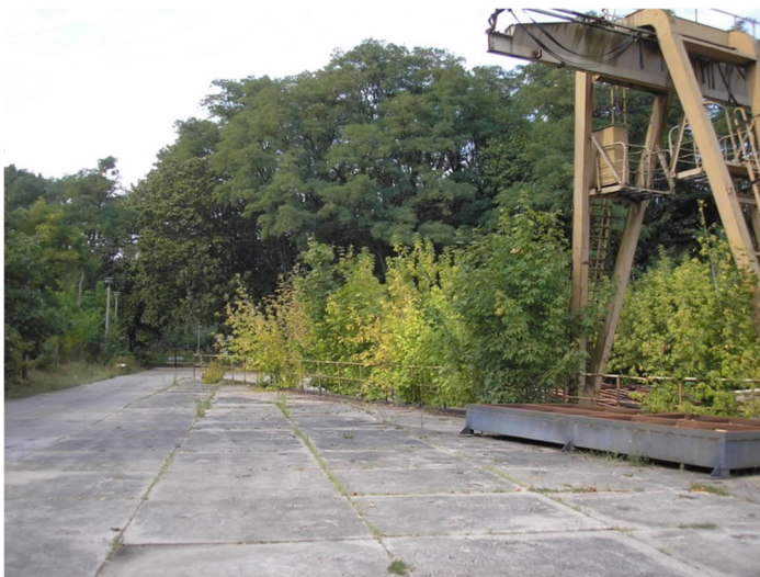
Abb. 23 Versiegelter Abschnitt in der Werft mit technischen Bauwerken und Spontanvegetation
