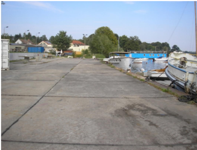
Abb. 22 Versiegelter Hafenbereich am Kalksee, durch Spundwand gesichert
