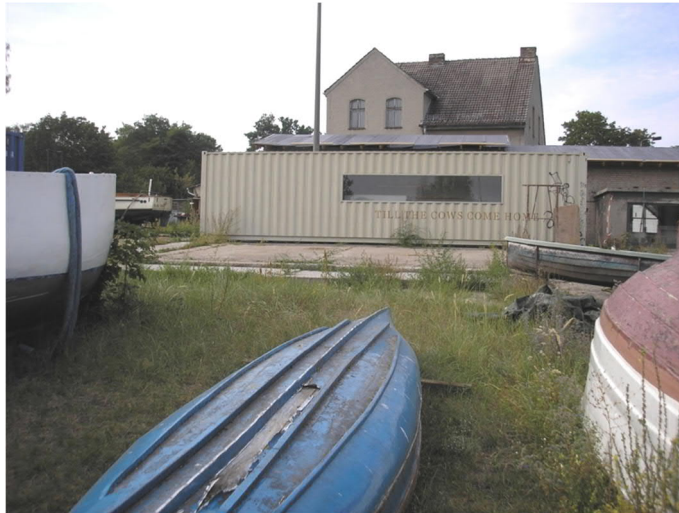
Abb. 10 Ehemalige Slipanlagen, heute Bootslagerplatz, mit ruderalen Fluren (Pionierrasen, Landreitgras)
