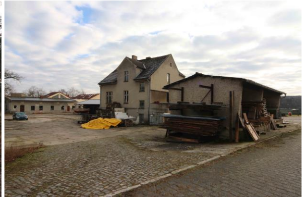
Abb. 3: Gebäude auf dem Werftgelände
