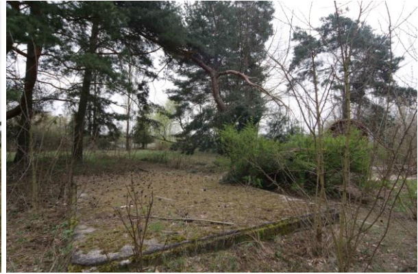
Abb. 15: Fundament eines Ferienhauses
