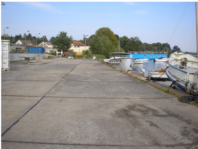
Versiegelter Hafbereich am Kalksee, durch Spundwand gesichert.
