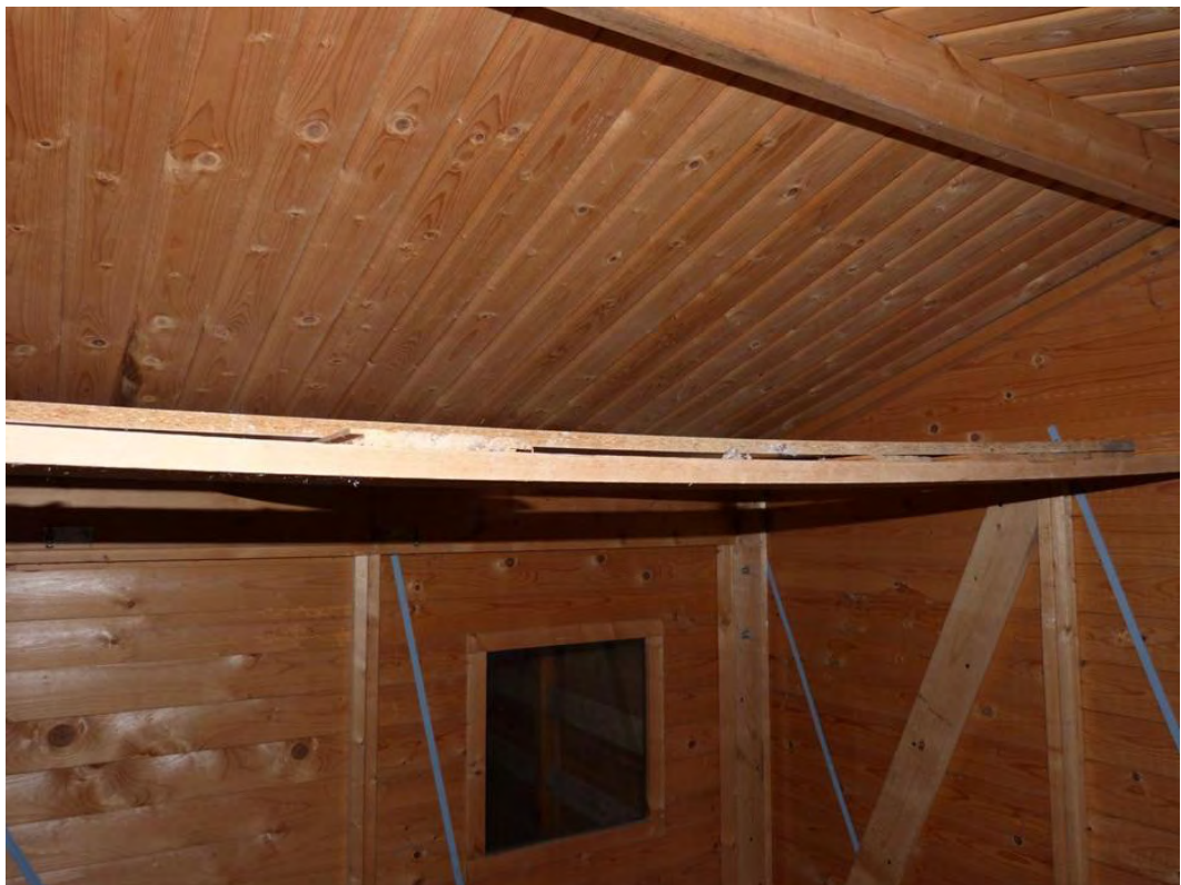
Bild 16: Untersuchung Schuppen im Südteil des Wohngrundstücks Flst. 669/3
