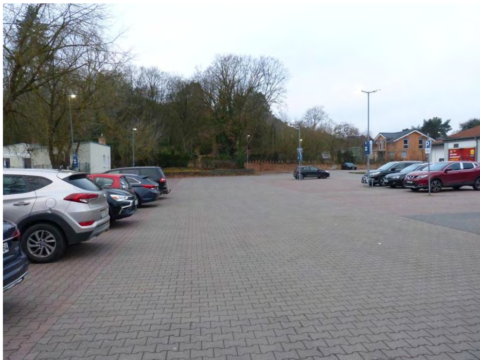
Bild 2: Vollversiegelte Fahr- und Parkflächen im Südteil des LIDL-Einkaufsmarktes
