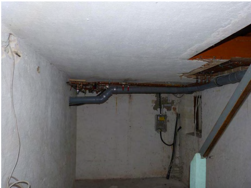
Bild 26: Untersuchung Keller Wohnhaus Flst. 669/2
