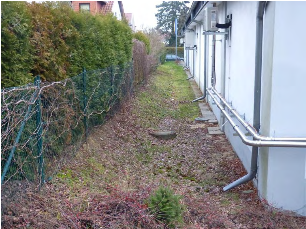
Bild 7: Mit Rasen begrünte Sickermulde mit Schotterbefestigung in Sohle nördlich LIDL-Gebäude
