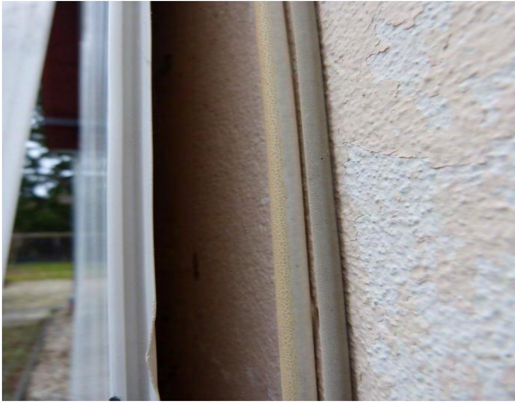
Bild 31: Untersuchung verkleidete Fassade Wohnhaus Flst. 669/2
