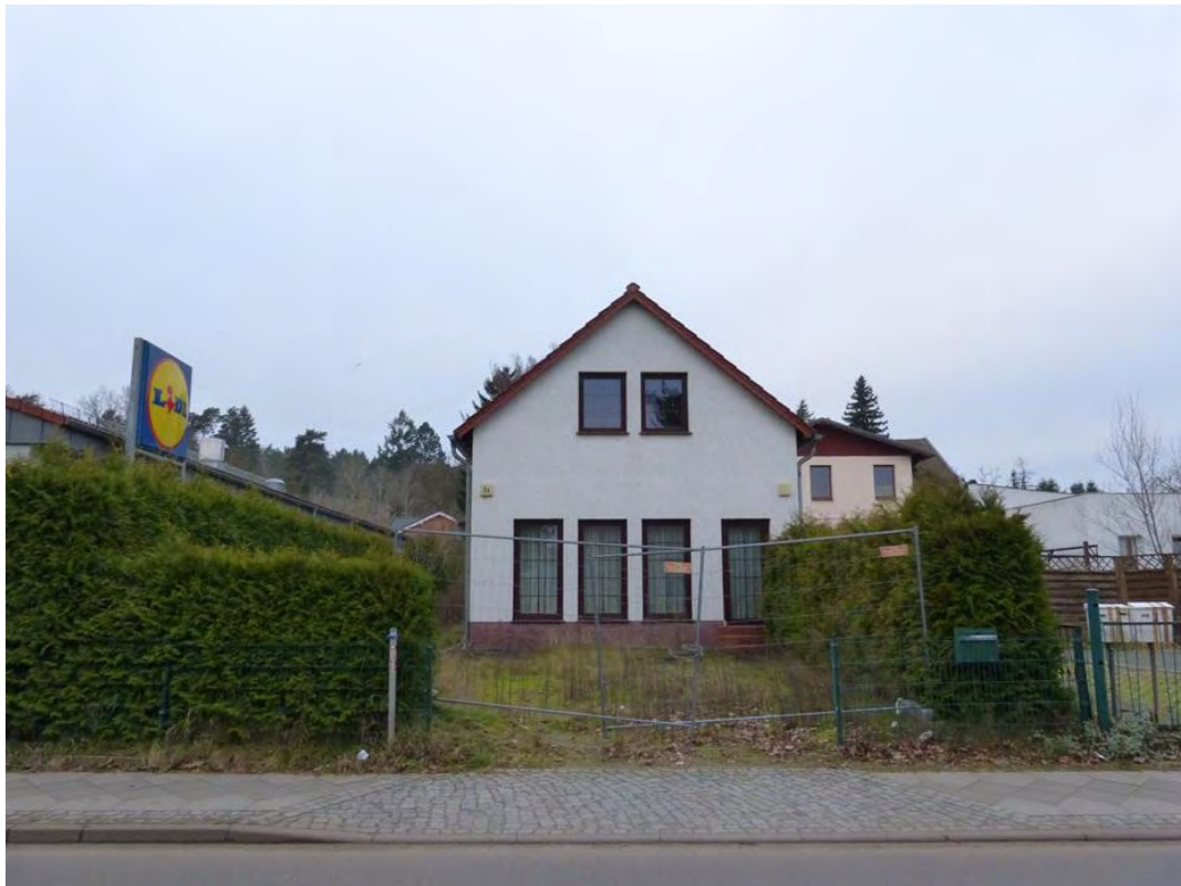
Bild 11: Blick von August-Bebel-Straße nach Westen auf Wohngrundstück Flst. 669/3
