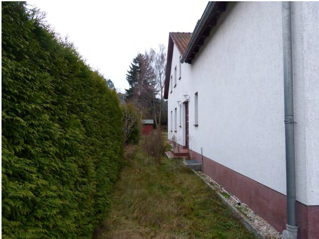
Bild 12: Blick auf Südseite Wohngrundstück Flst. 669/3
