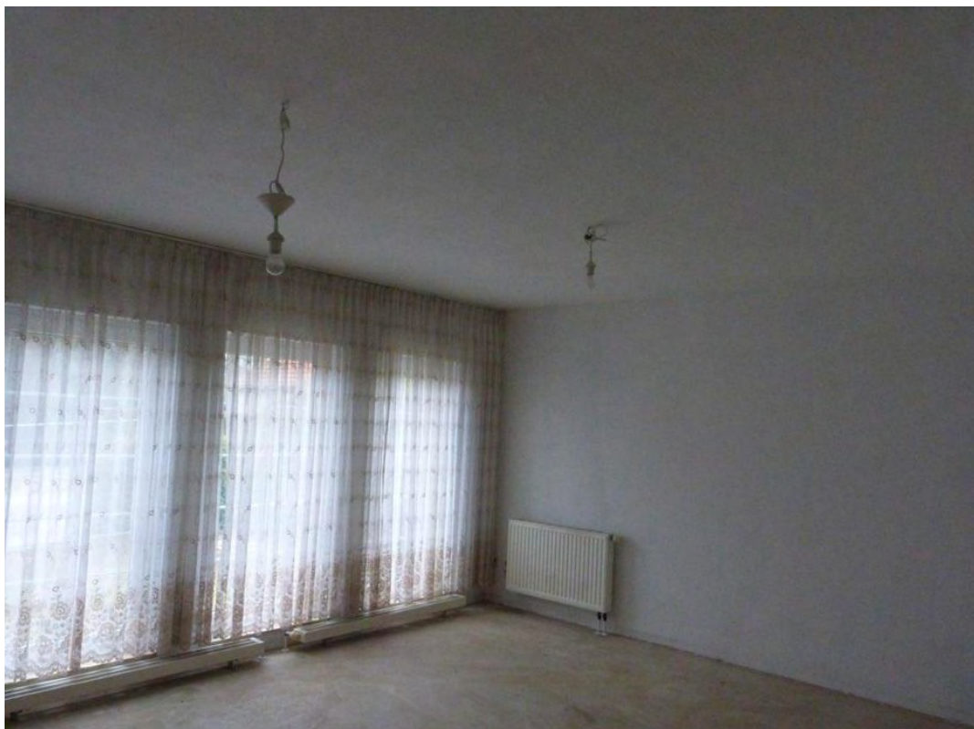
Bild 18: Untersuchung Erdgeschoss im Wohnhaus Flst. 669/3
