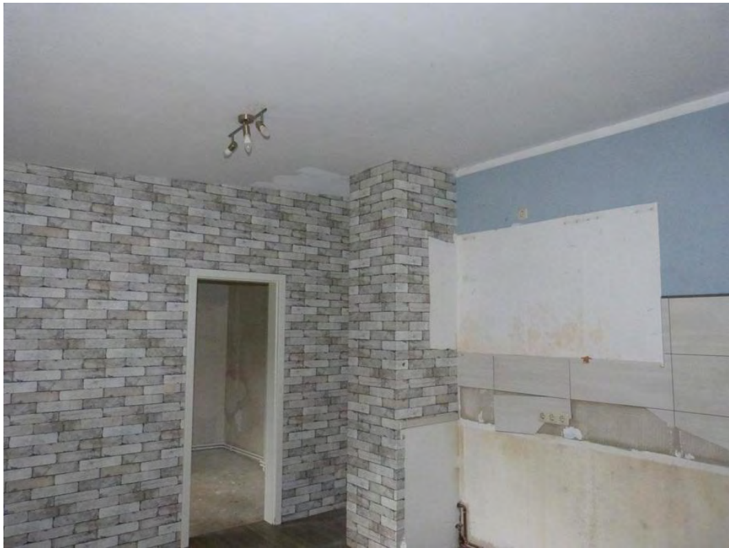
Bild 27: Untersuchung Erdgeschoss Wohnhaus Flst. 669/2
