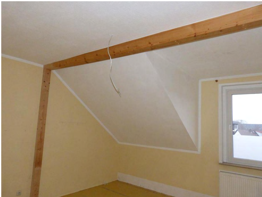
Bild 28: Untersuchung Dachgeschoss Wohnhaus Flst. 669/2
