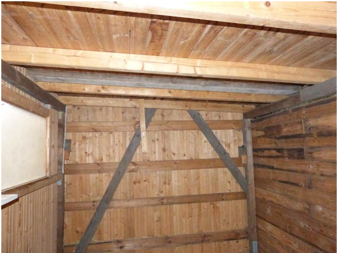
Bild 25: Untersuchung Schuppen in Wohnhaus Flst. 669/2
