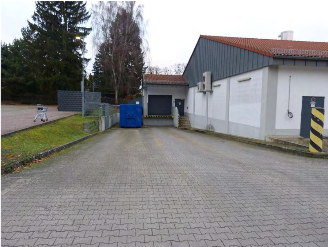
Bild 5: Blick auf Anlieferbereich mit Ladezone an der Westseite des LIDL-Einkaufsmarktes
