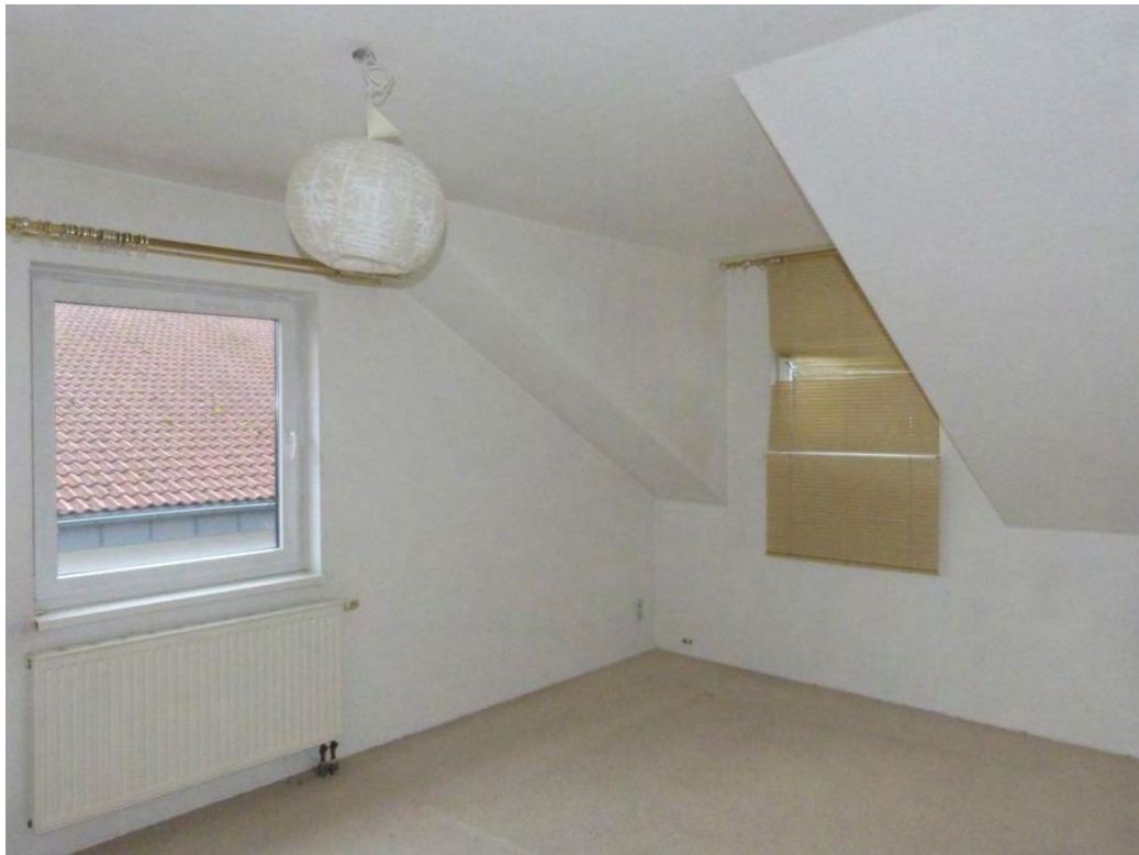
Bild 19: Untersuchung Dachgeschoss im Wohnhaus Flst. 669/3
